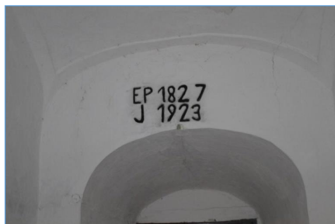
A templom kívülről (falán hatalmas repedéssel) és az építés és az egyik felújítás évszáma a templombelső falán.
